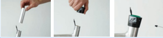
155. ábra: Siklópersely és külső hüvely beépítése
